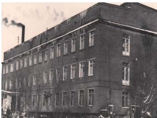
Рисунок 4 – Новое здание для областной станции переливания крови
